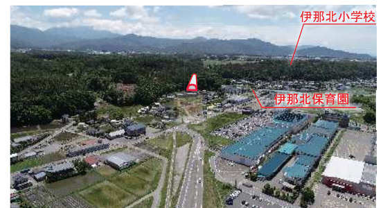
写真の手前側が供用中の伊那バイパスです。バイパスは伊那北小学校方面に延伸し、さらに市街地へと進む計画です。
