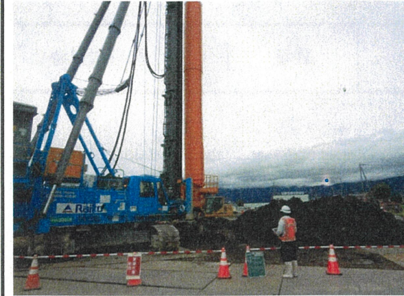
ICT活用工事(地盤改良工)全景
