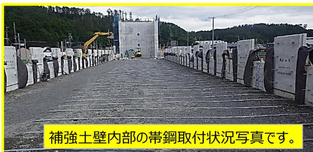
補強土壁内部の帯鋼取付状況写真です。
