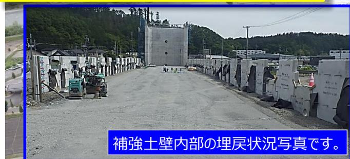
補強土壁内部の埋戻状況写真です。
